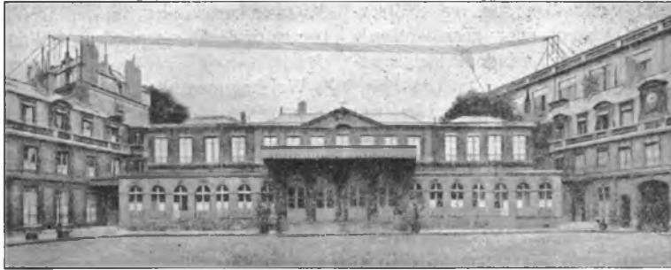
De antenne van P.T.T. op het Ministerie van Handel te Parijs. Gemiddelde energie 380 Watt (6 à 7 Amp.) in Antenne.
